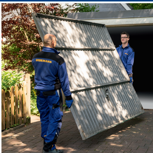
Desmontaje y eliminación respetuosa con el medio ambiente
